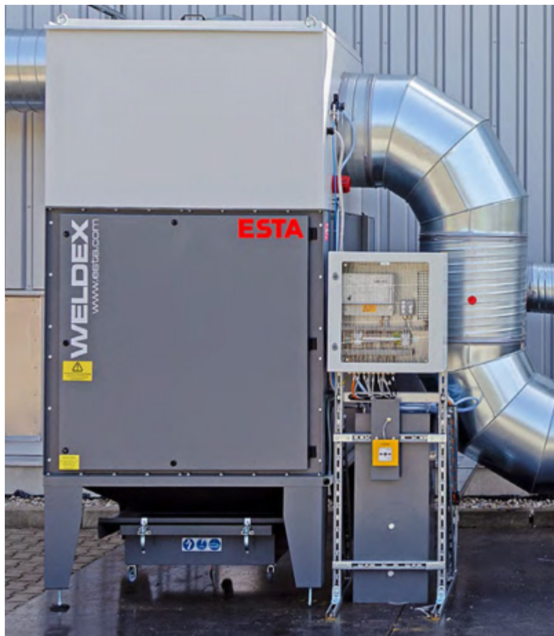
Suvirinimo dūmų ištraukimo sistemos centrinis filtras su gėsinimo sistema
